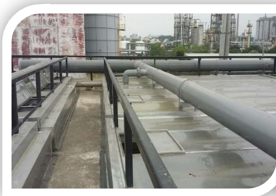
廢水池全面加蓋工程
