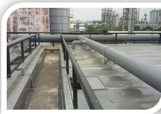
廢水池全面加蓋工程
