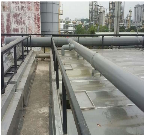
廢水池全面加蓋工程
