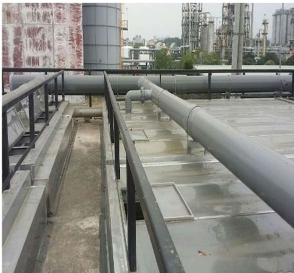
廢水池全面加蓋工程
